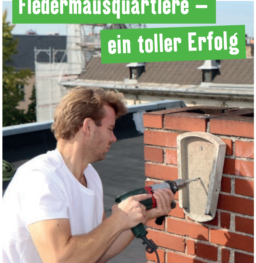
Julius Kiso bei der Installation eines Fledermausquartiers
