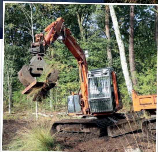
Renaturierungsarbeiten mit schwerem Gerät
